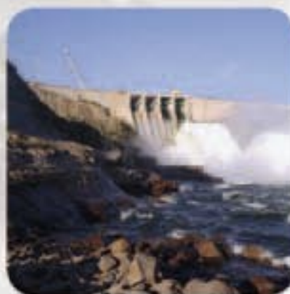
Usina Hidroelétrica de Capanda Angola
