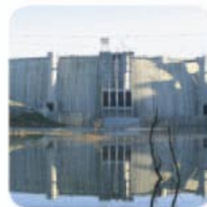
Barragem de Alqueva Portugal
