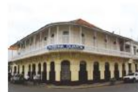
[ FIG. 2.34 ] Uma parte significativa dos edifícios residenciais que encontramos nas zonas urbanas mais consolidadas em S. Tomé têm áreas de envidraçado muito razoáveis. São uma boa referência para o projecto de novos edifícios. A área de envidraçado não deve exceder os 40% da superfície total das fachadas Norte ou Sul, e deve ser devidamente sombreada.
