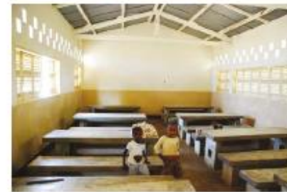
{ FIG. 2.36 } Uso de grilhas fixas de sombreamento, permitindo a passagem do fluxo de ventilação. Em cima edifício do Centro Cultural "Cacau"; em baixo edifício escolar.
