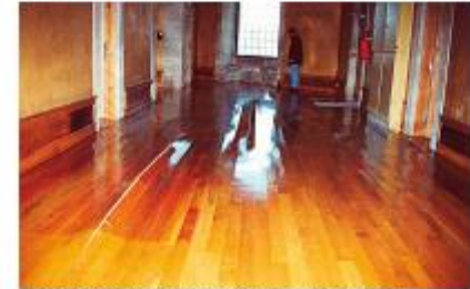
{ FIG. 3.5 } Inchaço da madeira após aplicação em obra.
