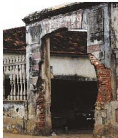
{ FIG. 3.20 } S. Tomé – cidade: paredes de tijolo cerâmico.
