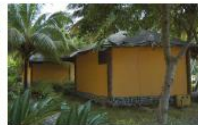
{ FIG. 2.20 } Bangalower de turismo em S. Tomé com sistema construtivo misto de coberturas. O isolamento é sobreponto em chapa ondulada de material metálico (sub-capa): aos benefícios da impermeabilização e durabilidade conferidos pelo uso da sub-capa metálica adiciona-se a capacidade isolante. Em alternativa, pode ser usado colmo (à esquerda), madeira, ou material cerâmico (telhas) com isolamento entre as duas camadas.
