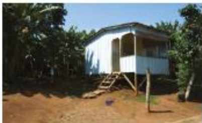
{ FIG. 2.26 } A pintura de cor clara reflecta o calor, evitando o sobreaquecimento no interior dos edifícios.
