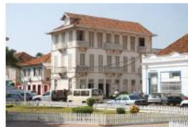
[ FIG. 2.34 ] Uma parte significativa dos edifícios residenciais que encontramos nas zonas urbanas mais consolidadas em S. Tomé têm áreas de envidraçado muito razoáveis. São uma boa referência para o projecto de novos edifícios. A área de envidraçado não deve exceder os 40% da superfície total das fachadas Norte ou Sul, e deve ser devidamente sombreada.
