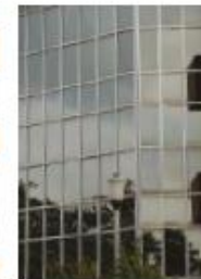
[ FIG. 2.33 ] Devem ser evitadas tipologias de fachadas com grandes áreas de envidraçado sem possibilidade de ventilação, largamente responsáveis pelo sobreaquecimento do interior do edifício, e consequente recurso a sistemas energívoros de ar condicionado. As fachadas com grandes áreas de envidraçado são uma tipologia importada, não se adequando ao clima quente de São Tomé e Príncipe.
