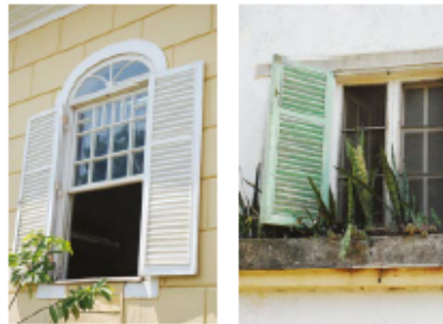
{ FIG. 2.35 } Portadas exteriores de moradias na cidade de S. Tomé; alças de sombreamento, permitam a direcção do fluxo de ventilação natural.
