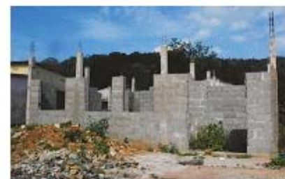
{ FIG. 3.24 } S. Tomé – Rural: construção com blocos de areia e cimento.
