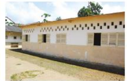
{ FIG. 2.36 } Uso de grilhas fixas de sombreamento, permitindo a passagem do fluxo de ventilação. Em cima edifício do Centro Cultural "Cacau"; em baixo edifício escolar.
