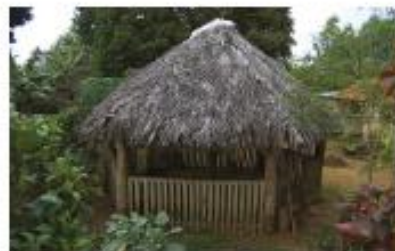
{ FIG. 2.20 } Bangalower de turismo em S. Tomé com sistema construtivo misto de coberturas. O isolamento é sobreponto em chapa ondulada de material metálico (sub-capa): aos benefícios da impermeabilização e durabilidade conferidos pelo uso da sub-capa metálica adiciona-se a capacidade isolante. Em alternativa, pode ser usado colmo (à esquerda), madeira, ou material cerâmico (telhas) com isolamento entre as duas camadas.
