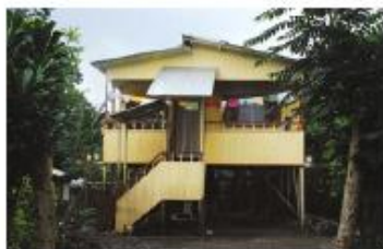
[ FIG. 2.56 ] Saída de ventilação em habitação típica (ventilação por efeito de chaminé).
