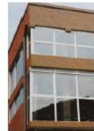
[ FIG. 2.33 ] Devem ser evitadas tipologias de fachadas com grandes áreas de envidraçado sem possibilidade de ventilação, largamente responsáveis pelo sobreaquecimento do interior do edifício, e consequente recurso a sistemas energívoros de ar condicionado. As fachadas com grandes áreas de envidraçado são uma tipologia importada, não se adequando ao clima quente de São Tomé e Príncipe.
