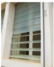
[ FIG. 2.56 ] Saída de ventilação em habitação típica (ventilação por efeito de chaminé).
