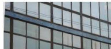
[ FIG. 2.33 ] Devem ser evitadas tipologias de fachadas com grandes áreas de envidraçado sem possibilidade de ventilação, largamente responsáveis pelo sobreaquecimento do interior do edifício, e consequente recurso a sistemas energívoros de ar condicionado. As fachadas com grandes áreas de envidraçado são uma tipologia importada, não se adequando ao clima quente de São Tomé e Príncipe.
