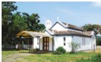
{ FIG. 2.26 } A pintura de cor clara reflecta o calor, evitando o sobreaquecimento no interior dos edifícios.
