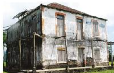
{ FIG. 3.21 } S. Tomé – Roças: paredes de alvenaria ordinária.
