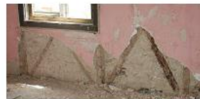
{ FIG. 3.22 } S. Tomé – Roças: paredes da frontal tipo pombalino.
